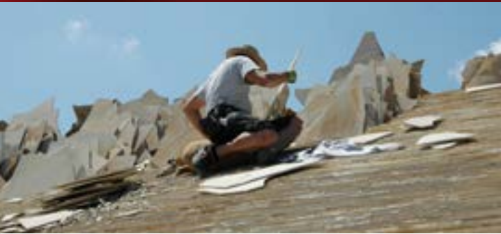
Ein Legschieferdach entsteht | Jurahäuser in Dettenheim
