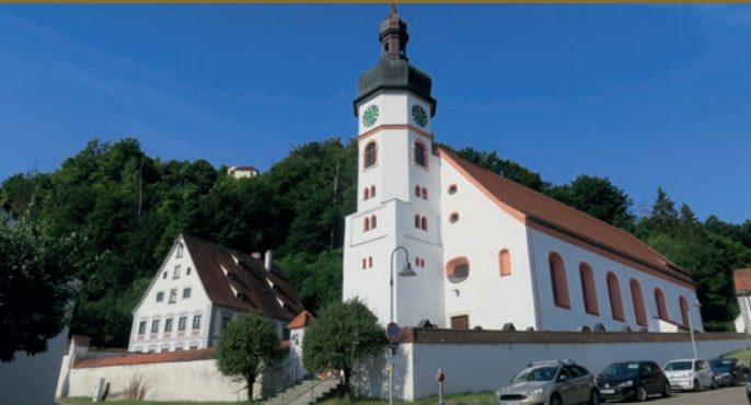
Der Kirchturm der Pfarrkirche St. Andreas.
