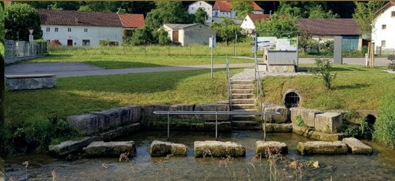
Die Wassertretenanlage ist in den natürlichen Flusslauf der Gailach integriert.
