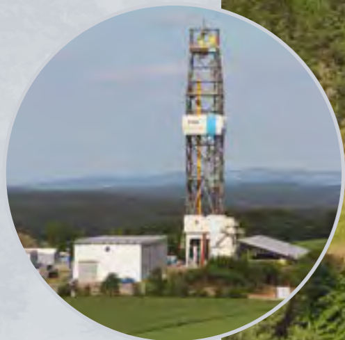
Blick in die Tiefe – Kontinentale Tiefbohrung KTB.
