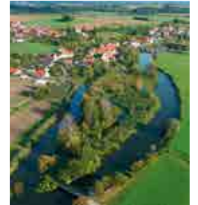
Wörnitz mit Mühlbach, typisch für die Nutzung der Wasserkraft ist die Aufspaltung in Mühlbach (linker Wasserarm) und Unterlauf. Der Wasserstand wird durch ein Wehr reguliert (Bildvordergrund).
