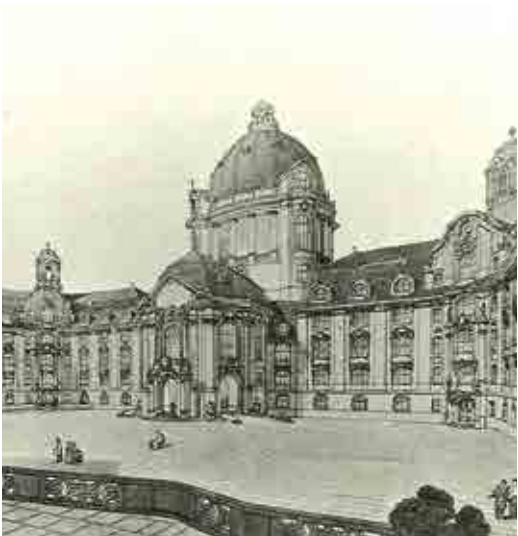
In München wurde am ehemaligen Bayerischen Verkehrsministerium mit Suevit gebaut.
